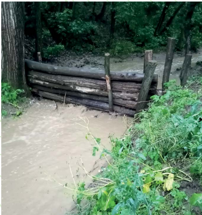
Püspökszilágy vízvisszatartó és eróziócsökkentő rendszere áradás alatt és után. Forrás: Tordai Sándor, Püspökszilágy Önkormányzat
